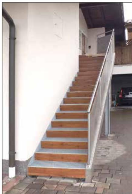
Dauerhafte und optisch ansprechende Lösungen für den Outdoorbereich sind eine unserer Stärken, wie z. B. Außenstiegen in Stahlversion bei bestehenden Gebäuden. Trittstufeneinlagen aus rutschhemmenden Gitterrost und Spiegelverkleidung komplettieren die Treppe. Trittauflagen aus Stein, Granit oder Holzstufen sind ebenfalls möglich. Gerne realisieren wir Geländer und Handläufe nach Kundenwünschen.
