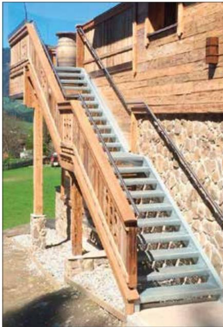
Dauerhafte und optisch ansprechende Lösungen für den Outdoorbereich sind eine unsere Stärken, wie z. B. Außenstiegen in Stahlversion bei bestehenden Gebäuden. Trittstufeneinlagen aus rutschhemmenden Gitterrost und Spiegelverkleidung komplettieren die Treppe. Trittauflagen aus Stein, Granit oder Holz sind ebenfalls möglich. Gerne realisieren wir individuelle Geländer und Handläufe nach Kundenwünschen.
