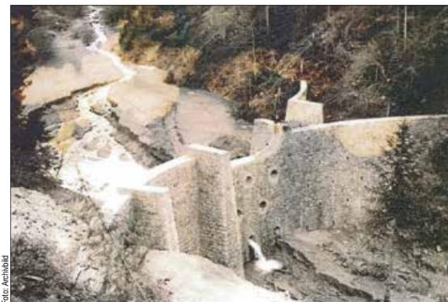
Die Gewölbesperre mit Brückenpfeilern nach der Fertigstellung im Jahr 1962 mit 57.000 m³ Stauraum.
